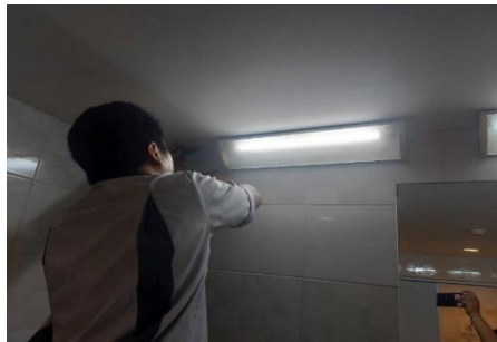
ซ่อมแซมระบบไฟฟ้าส่องสว่าง
